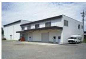
電波暗室・外観
